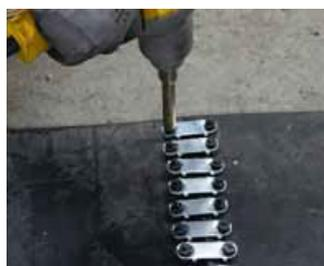
9| Apretar fuertemente las tuercas\* con el atornillador equipado con el adaptador especial de apriete alternando los 2 extremos.
