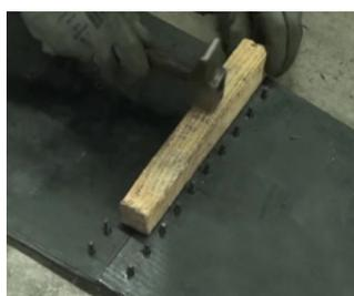
6| Hacer entrar profundamente los tornillos en la banda. Colocar una cuña entre los tornillos y golpear ligeramente con el martillo.
